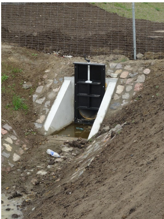
Insp. 11. Przykładowa konstrukcja zakładki żelbetowej https://inzynieriasrodowiska.com.pl/encyklopedia/zastawki-w-rowach-melioracyjnych
