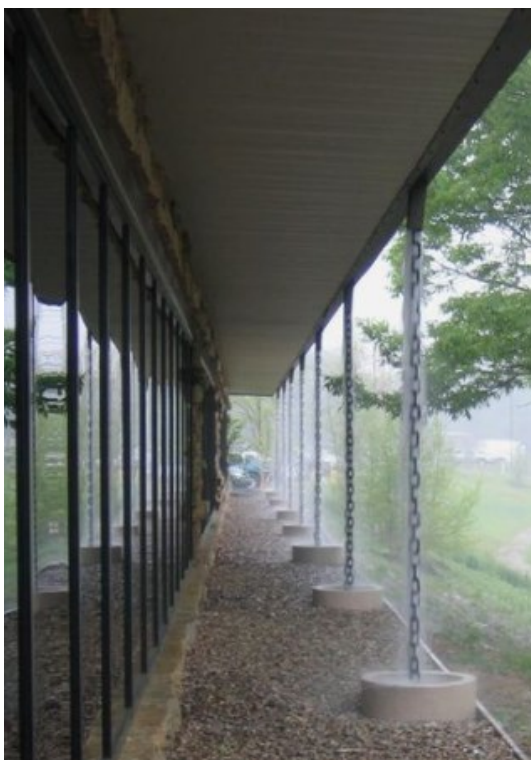
Insp. 28. Przykładowe rozwiązanie odprowadzenia wody z dachu za pomocą łańcuchów stalowych https://pl.pinterest.com/
